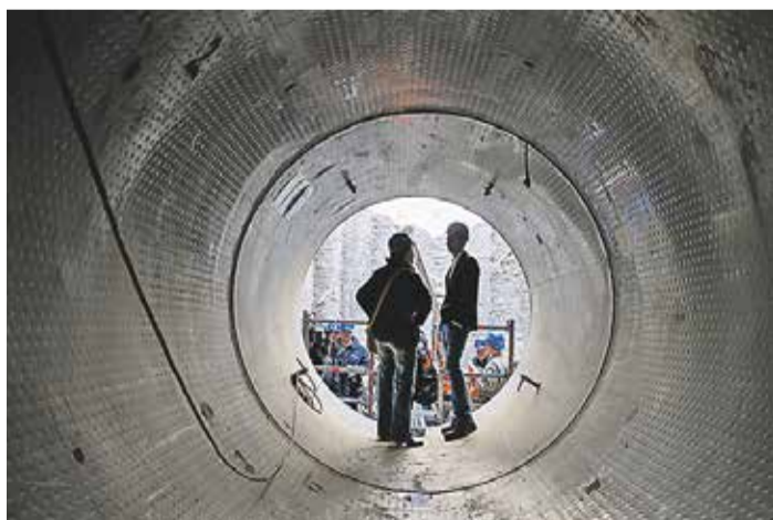
Journalisten besichtigen ein Abwasserrohr in Hamburg Foto: dpa
